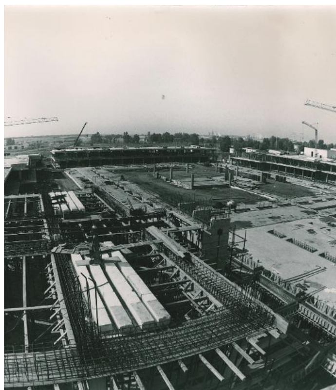
Il cantiere del Centro Orafo Il Tarì: l'inizio di una visione che avrebbe trasformato il comparto orafa
